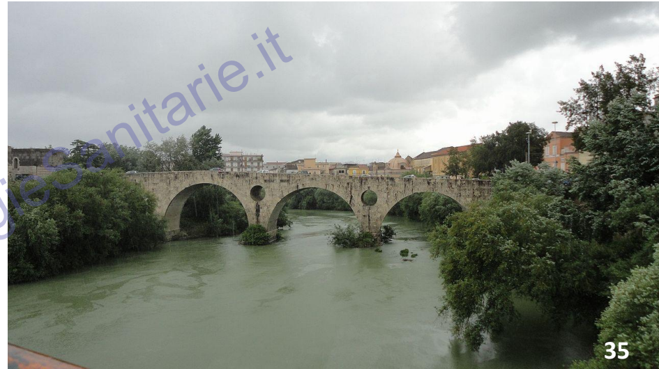
Ponte sul fiume Volturno a Capua
